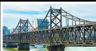
สะพานหวาดตานตง
